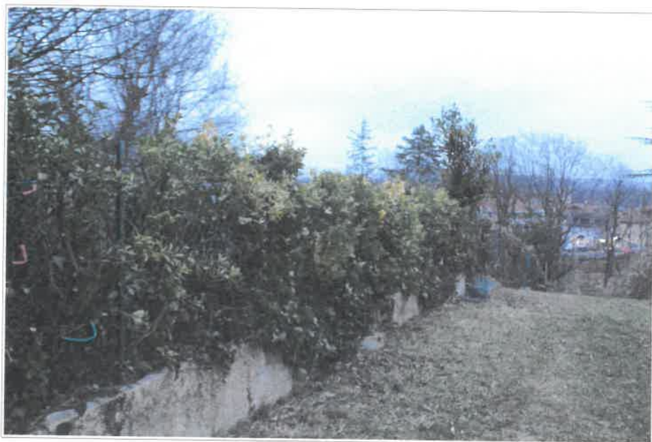
Photo n° 5 : la clôture de la propriété Martinez-Rodeiro en partie haute du passage
